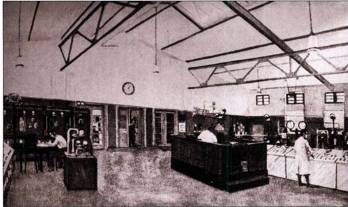
Bild 3: Im Sendersaal von Haus 4; rechts ist der Langwellensender des Deutschlandsenders zu sehen, am linken Bildrand ein Teil des Weltrundfunksenders .
